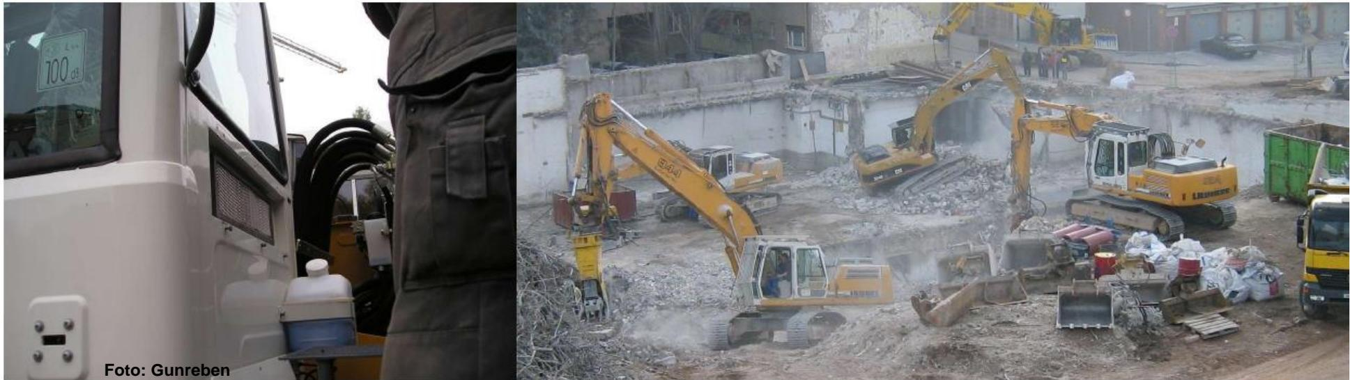
Einsatz von Maschinen mit Zulufffilter bei staubintensiveren Tätigkeiten
